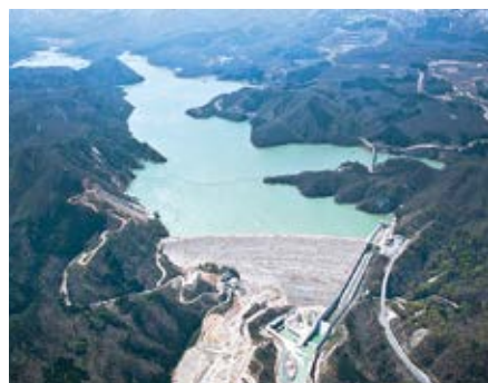
胆沢ダム／平成25年完成。わが国最大級の中央コア型ロックフィルダムです。
